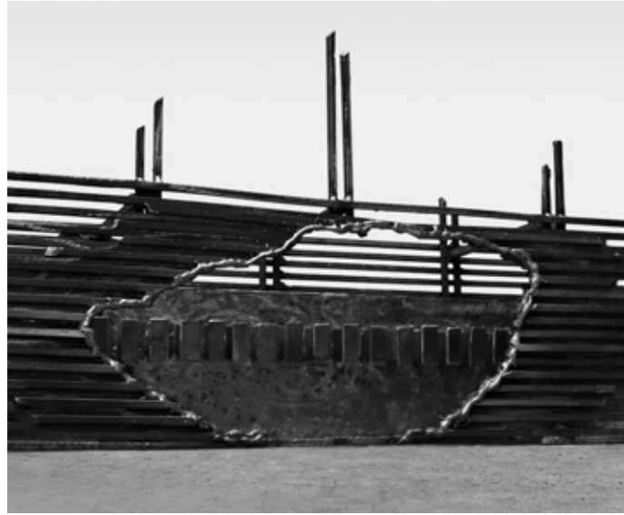
Detailansichten: Aufbruch Widerstand
